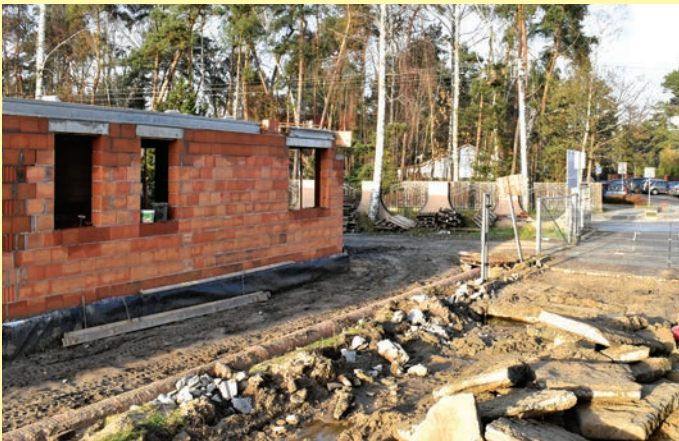
Rozbudowa przedszkola w Międzyborowie
