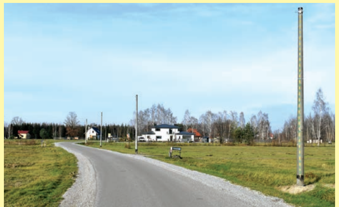
Stare Budy, ul. Chopina – oświetlenie uliczne
