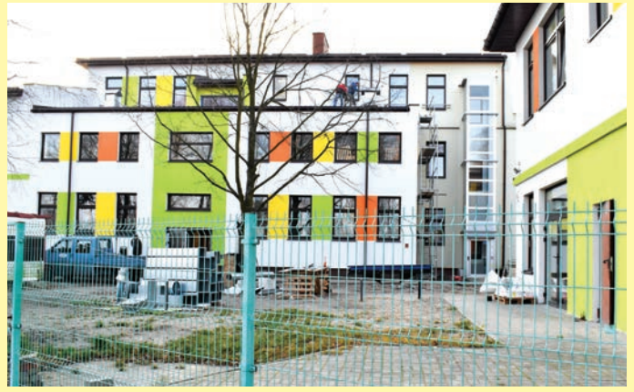
Rozbudowa szkoły podstawowej w Jaktorowie
