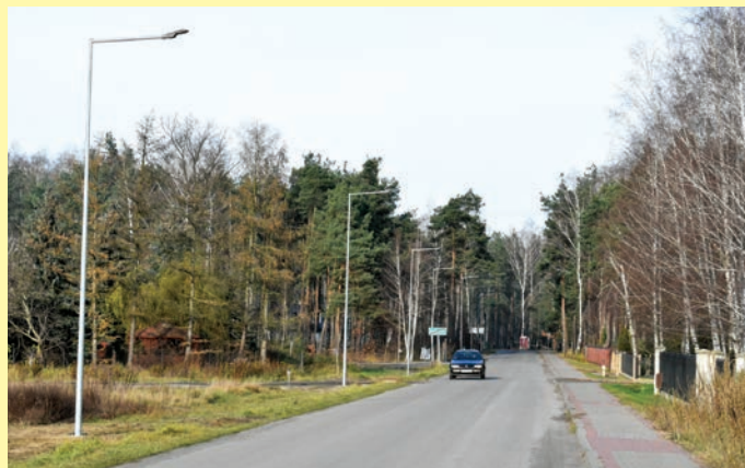
Bieganów, ul. Topolowa – oświetlenie uliczne
